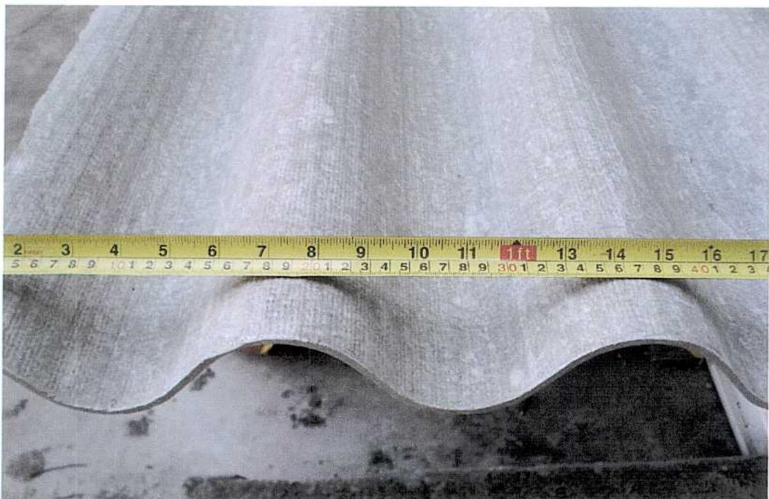
**Foto 2:** Perfil de uma telha que compõe o telhado T2.
