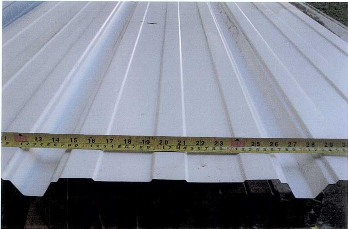
**Foto 1:** Perfil de uma telha que compõe o telhado T1.
